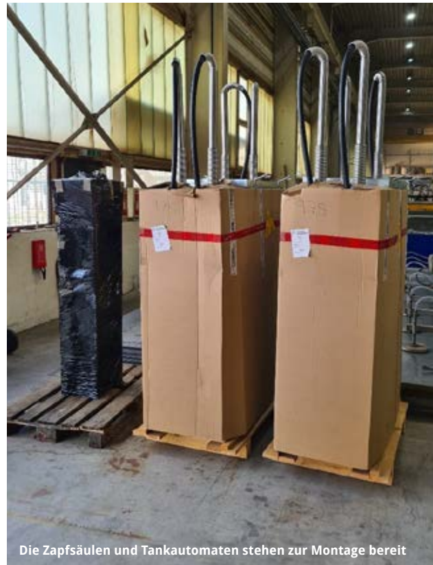
Flüssigkeitsdichte Betankungsfläche und Vorbereitung eines Containerfundaments
